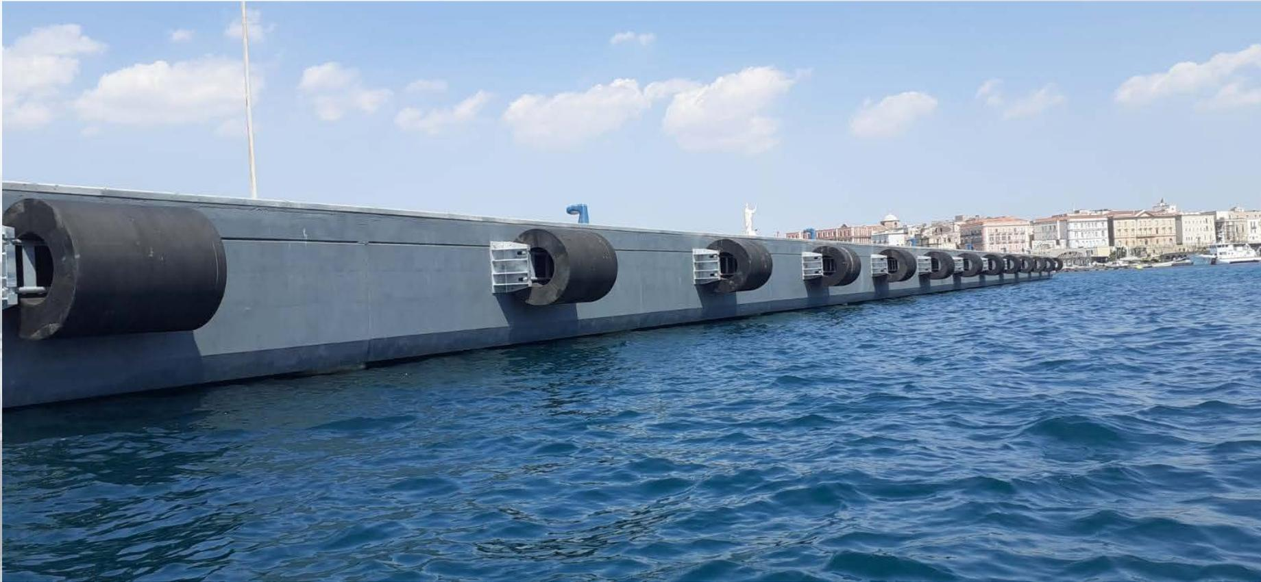
E' in grado di permettere l'accosto su 200 m lineari, attrezzata con 10 bitte e 20 parabordi.
